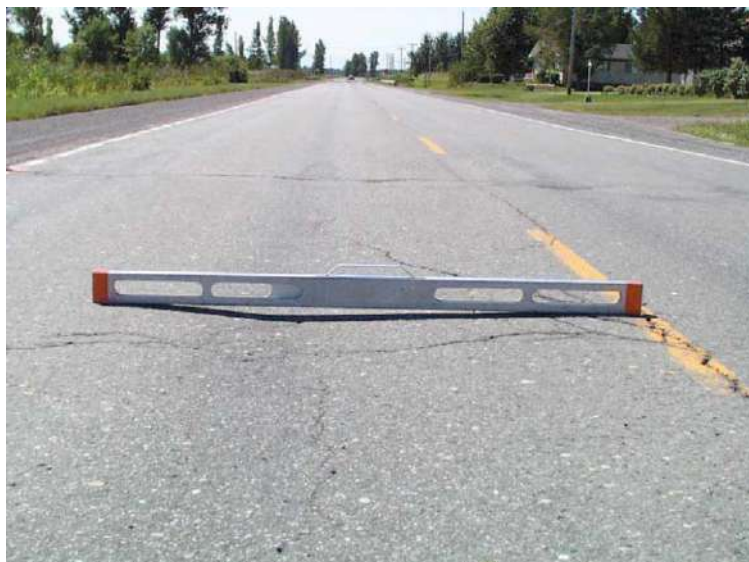
Εικόνα 3.5: Απεικόνιση της παραμένουσας παραμόρφωσης στο οδόστρωμα
