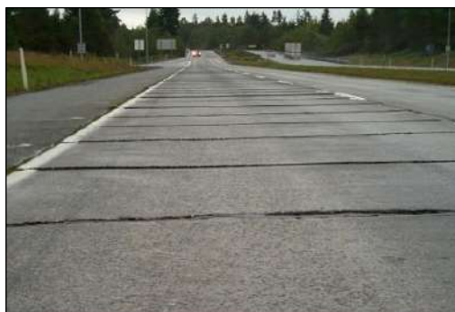
Εικόνα 2.25 Παράδειγμα ανισοσταθμίας πλακών σε δύσκαμπτο οδόστρωμα
