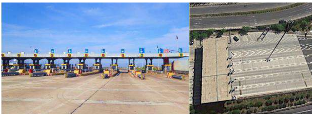
Εικόνα 2.2 Δύσκαμπα οδοστρώματα σε δάπεδα διοδίων
