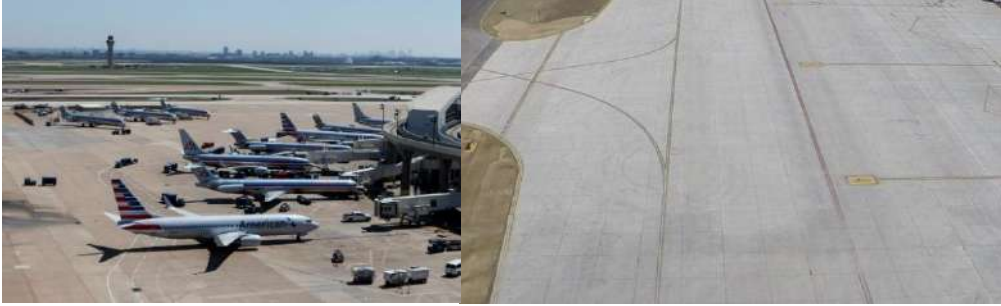
Εικόνα 2.3 Δύσκαμπα οδοστρώματα σε δάπεδα στάθμευσης αεροδρομίων
