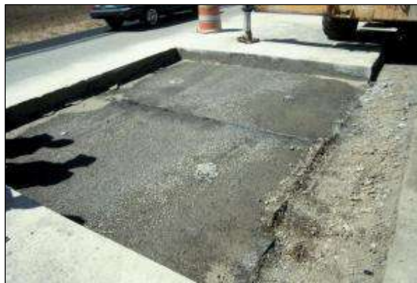
Εικόνα 3.11 Επισκευή πλήρους βάθους-Παράγοντας P του δείκτη PSI
