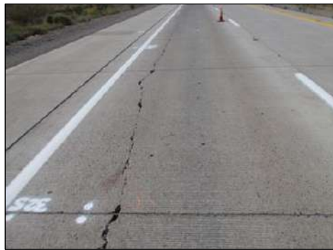
Εικόνα 2.31 Οριζόντια ρηγμάτωση σε δύσκαμπτο οδόστρωμα
