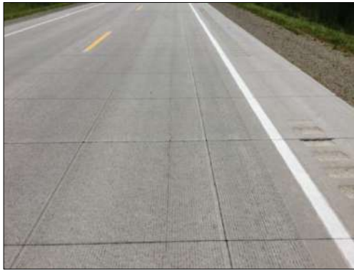
Εικόνα 2.11 Οδόστρωμα από άοπλο σκυρόδεμα με αρμούς (JPCP)
