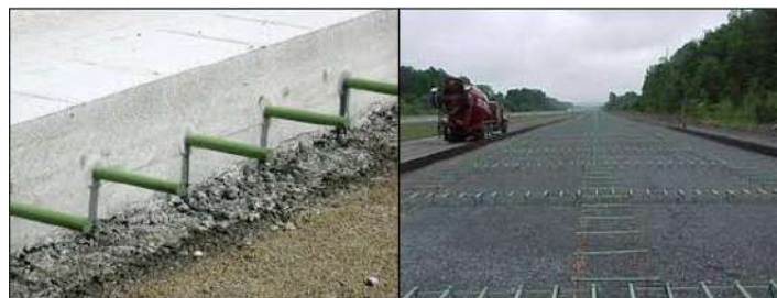
Εικόνα 2.18 Βλήτρα σε δύσκαμπτα οδοστρώματα
