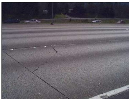
Εικόνα 2.29 Ρηγμάτωση άκρου σε δύσκαμπτο οδόστρωμα
