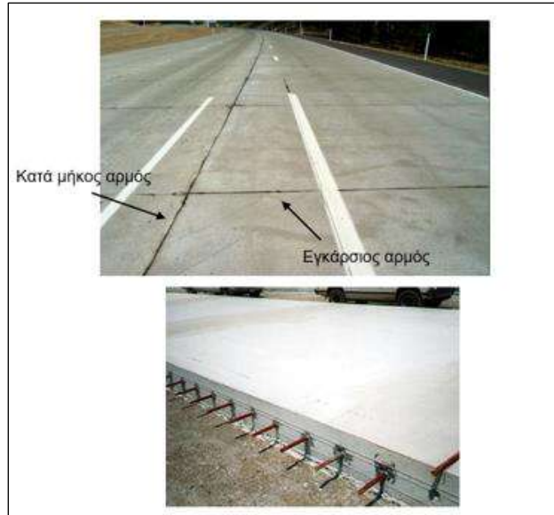
Εικόνα 2.17 Παραδείγματα αρμών δύσκαμπτων οδοστρωμάτων
