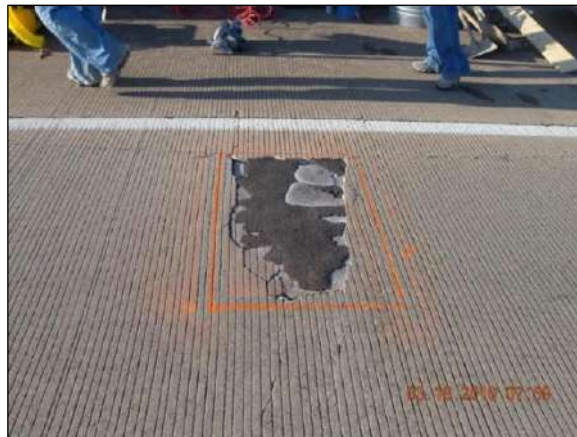
Εικόνα 3.10 Τοπικές επισκευές (μπαλώματα)-Παράγοντας P του δείκτη PSI
