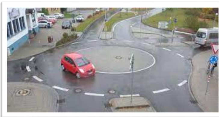
Εικόνα 2.6.1: Κυκλικός κόμβος μιας λωρίδας.[38]
