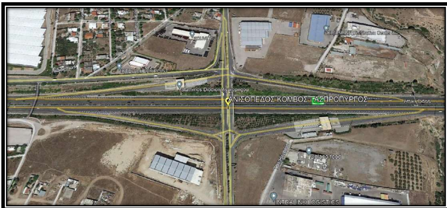
Εικόνα 7 : Ανισόπεδος κόμβος «διαμάντι» στην Αττική Οδό, στην περιοχή του Ασπρόπυργου, Πηγή : Google Earth.
