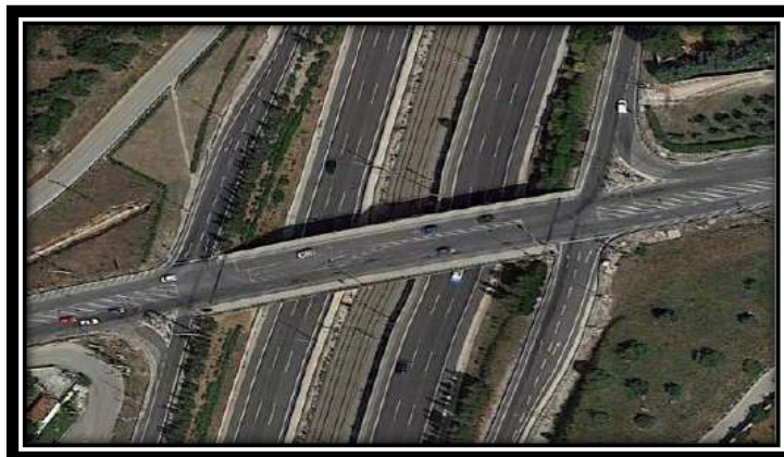
Εικόνα 3 : Τυπική μορφή ανισόπεδου κόμβου μορφής «διαμάντι», Πηγή : Ιστότοπος www.mycourses.com.gr , Μάθημα Ειδικά κεφάλαια Γεωμετρικού σχεδιασμού οδών.
