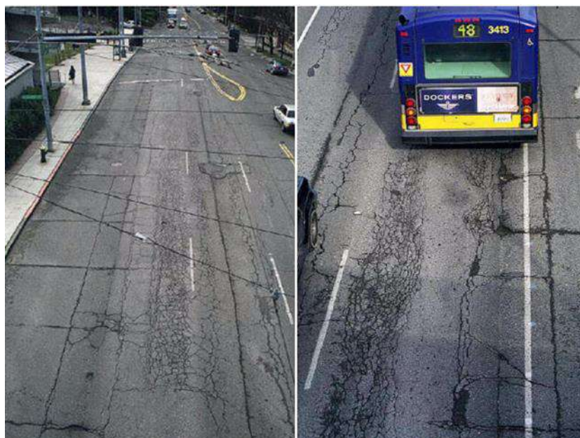
Εικόνα 2.4: Προκύπτουσα φθορά από σημαντική αύξηση των Ισοδύναμων Τυπικών αξόνων, λόγω αύξησης της κυκλοφορίας των λεωφορείων
