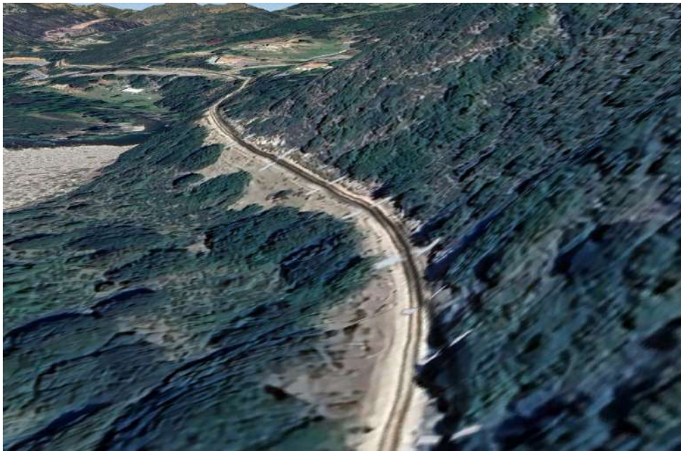
Εικόνα 2.7 - Τμήμα χάραξης στις παρυφές ορεινού όγκου στην Κορσική. Με τον γεωμετρικό σχεδιασμό μας επιδιώκουμε να «αγκαλιάσουμε» τις ισούψείς και να ακολουθήσουμε κατά το δυνατόν τις φυσικές κλίσεις του εδάφους (Google Earth)
