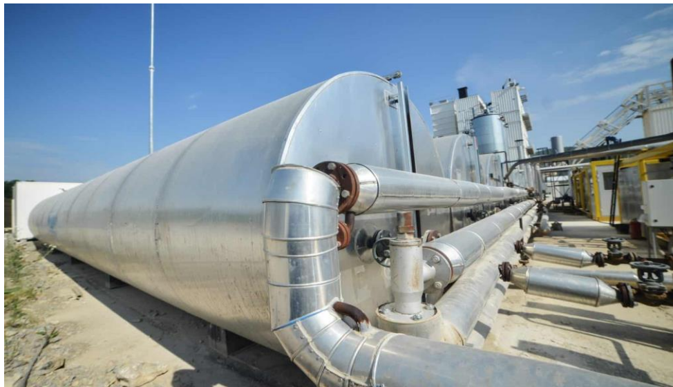
Εικόνα 2.28: Αγωγοί μεταφοράς ασφάλτου (από προσωπικό αρχείο)
