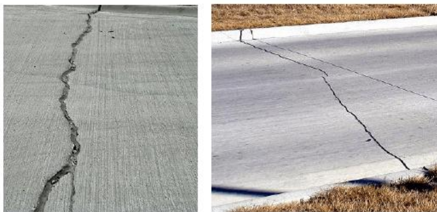
Εικόνα 3.1: Εγκάρσια Ρηγμάτωση (Jung, Freeman, & Zollinger, 2008)
