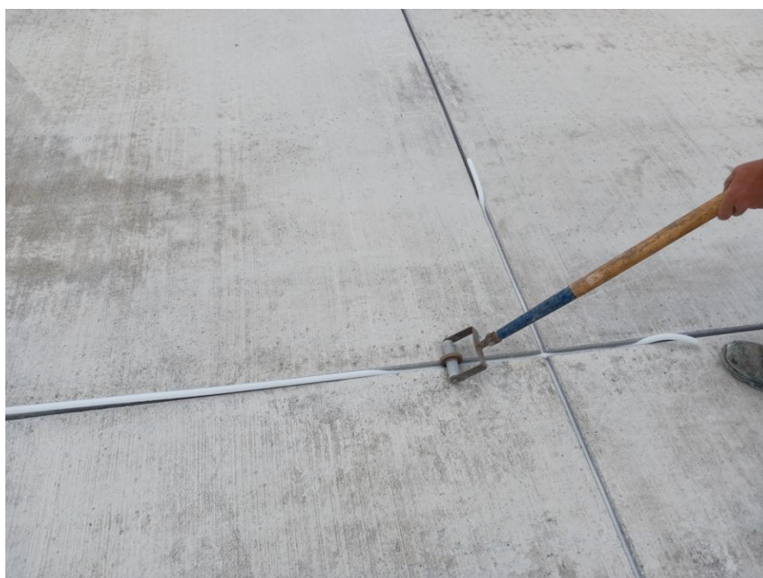
Εικόνα 4.3: Τυπική Διαδικασία Στεγανοποίησης Αρμών
