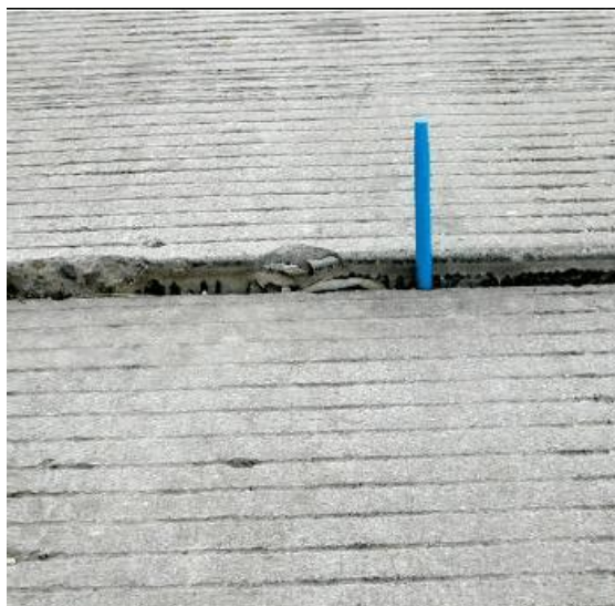
Εικόνα 3.3: Ανισοσταθμία Γειτονικών Πλακών (Jung, Freeman, & Zollinger, 2008)
