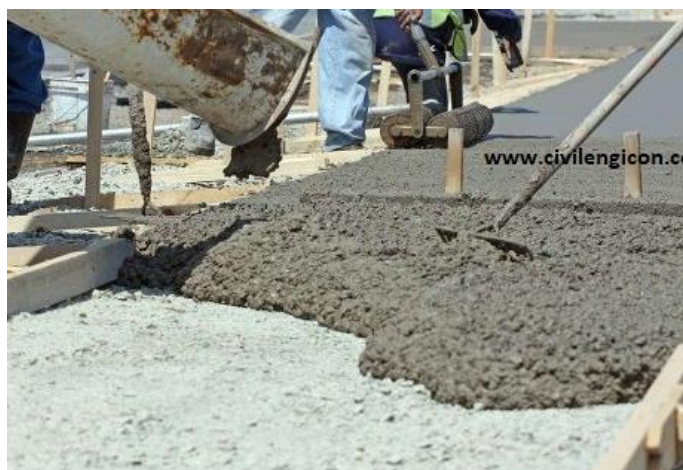
Εικόνα 2.11: Διάστρωση Διατομής JPCP https://www.civilengicon.com/
