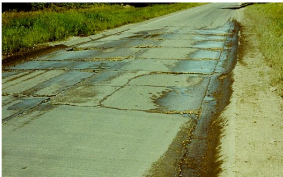
Εικόνα 3.16: Άντληση και Διαρροή Νερού (Gerges, 2009)
