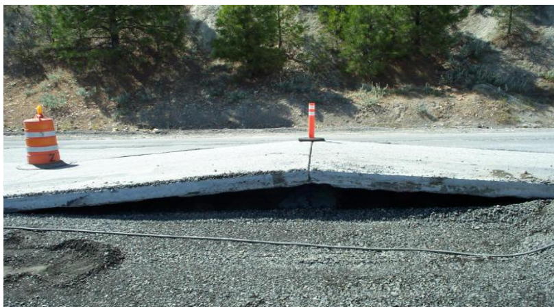
Εικόνα 3.9: Ήβωση Δύσκαμπτου Οδοστρώματος/ SR 195- Ουάσιγκτον (Gerges, 2009)
