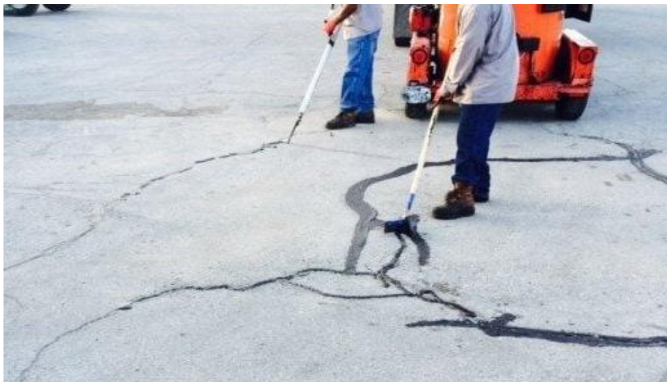
Εικόνα 4.4: Τυπική Διαδικασία Σφράγισης Ρωγμών
